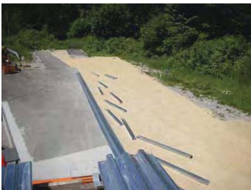
5. Auslegen der Pfosten und Stützbügel
