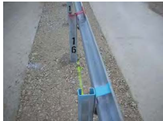
10. Fertig montierter Systemquerschnitt EASYRAIL
