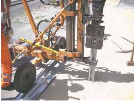
7. Rammen der Pfosten
