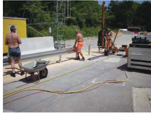
8. Vormontage der Stützbügel und der SP-Holme
