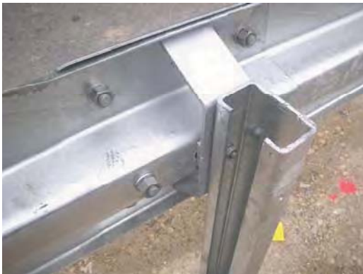
11. Detail fertige Verschraubung
