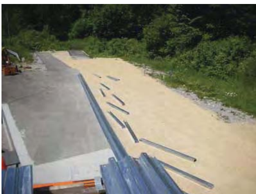
5. Auslegen der Pfosten und Stützbügel
