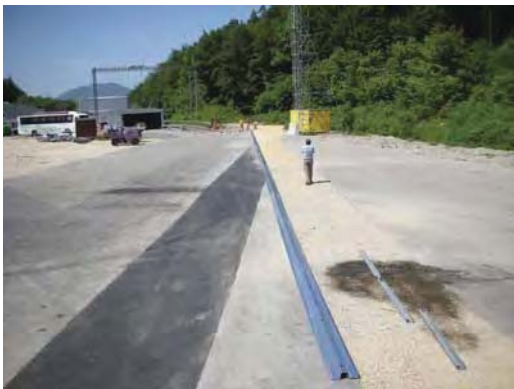
3. Ausrichten der SP Holme...
