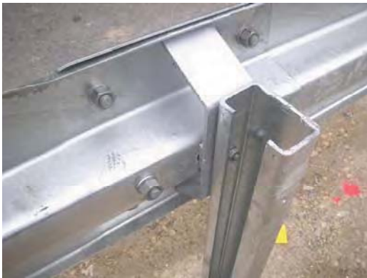
11. Detail fertige Verschraubung
