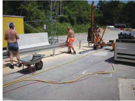
8. Vormontage der Stützbügel und der SP-Holme
