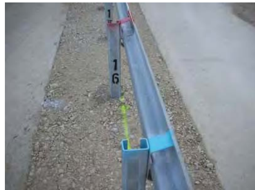
10. Fertig montierter Systemquerschnitt EASYRAIL
