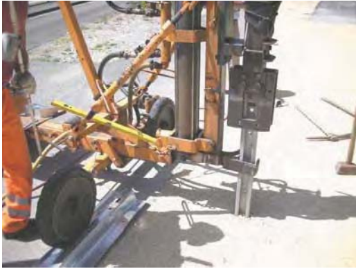
7. Rammen der Pfosten
