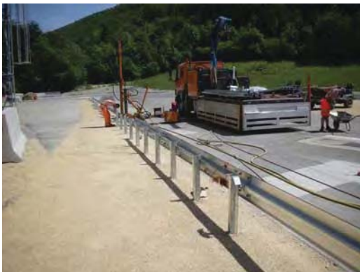
9. Montage erfolgt Zug um Zug mit dem Rammen der Pfosten
